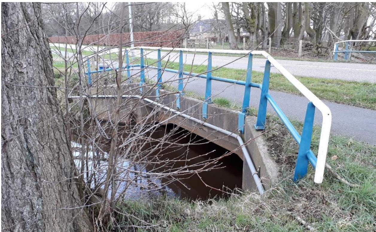
Figuur 3: foto van de duiker over de Boksloot (foto van RHDHV)
